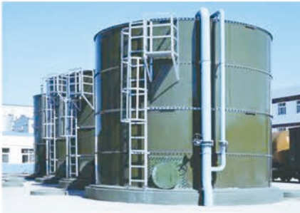
BAF污水处理设备
